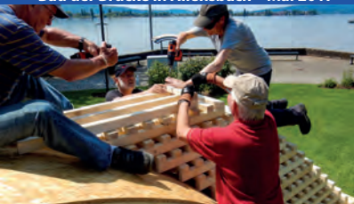
Bau der Brücke in Allensbach – Mai 2017
