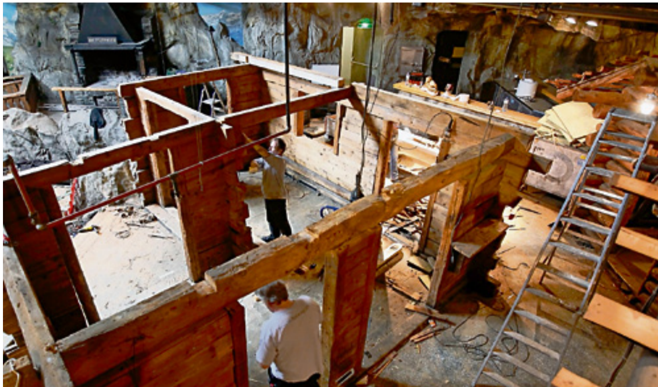
Alle Teile der «Alpenrock»-Chalets werden fein säuberlich durchnummeriert, damit am neuen Ort alles wieder passt. Bilder: Madeleine Schoder
